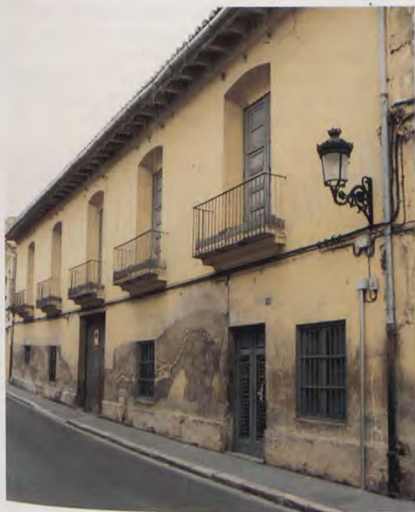
GODELLA. Fachada principal de la casa solariega de la marquesa de Llanera.
